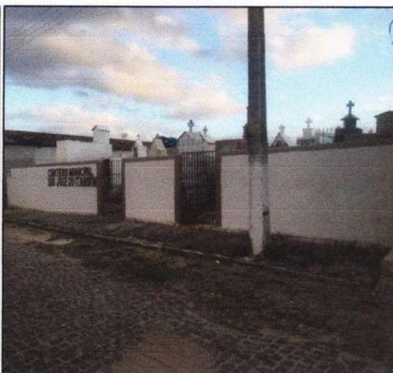
Fachada frontal do muro do cemitério
