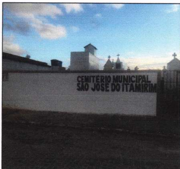
Fachada frontal do muro do cemitério
