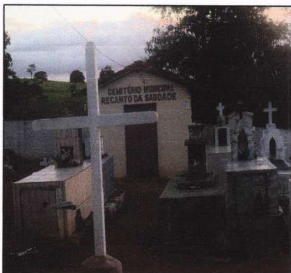
Fachada frontal da capela
