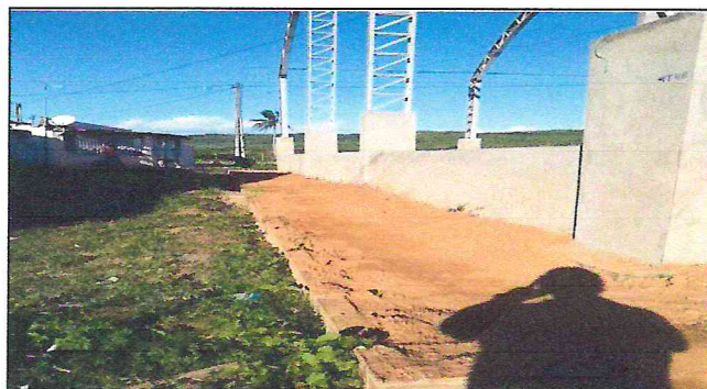
Foto 02: Aterro para passeio
