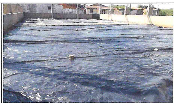
Foto 11: Instalação de lona para piso de concreto
