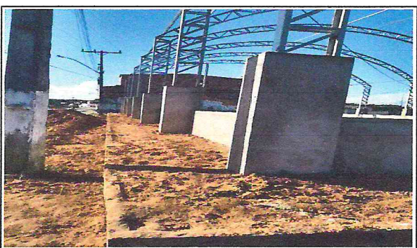
Foto 03: Aterro para passeio
