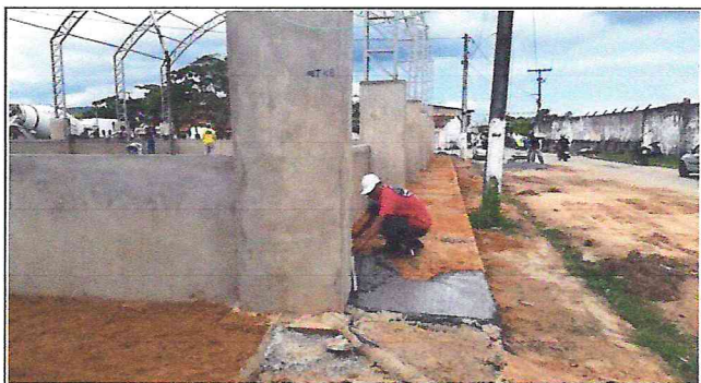
Foto 06: Concreto para passeio
