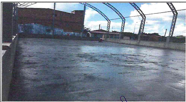
Foto 16: Concreto usinado lançado
