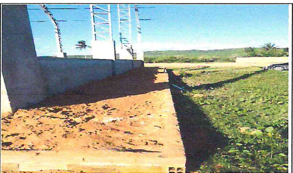
Foto 05: Aterro para passeio concluído
