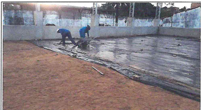
Foto 08: Colocação de lona para piso
