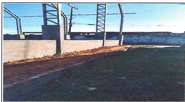
Foto 04: Aterro para passeio concluído
