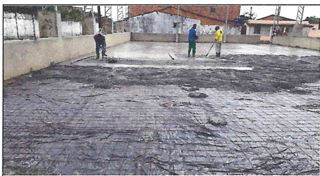
Foto 12: Instalação de tela TELCON
