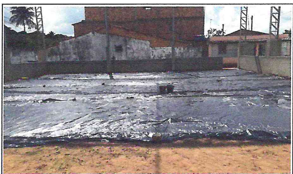
Foto 13: Instalação de lona para piso de concreto
