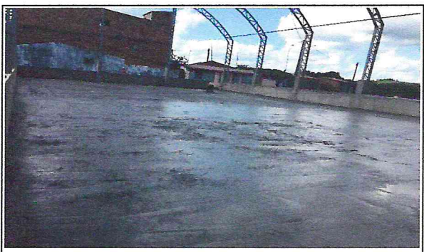
Foto 15: Concreto usinado lançado
