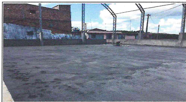
Foto 10: Lançamento de concreto
