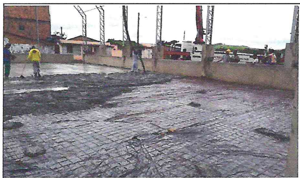
Foto 09: Instalação de tela TELCON
