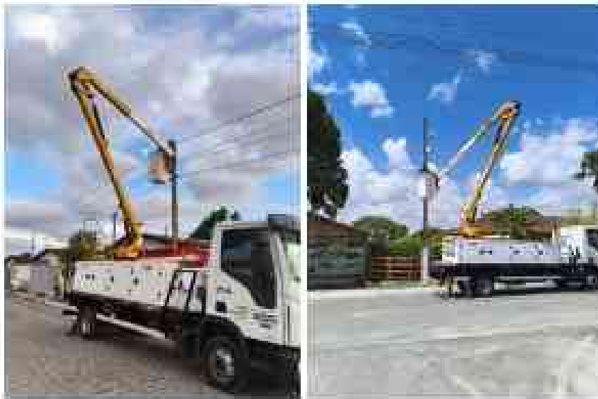
Figura 3 – Manutenção do sistema de Iluminação Pública
