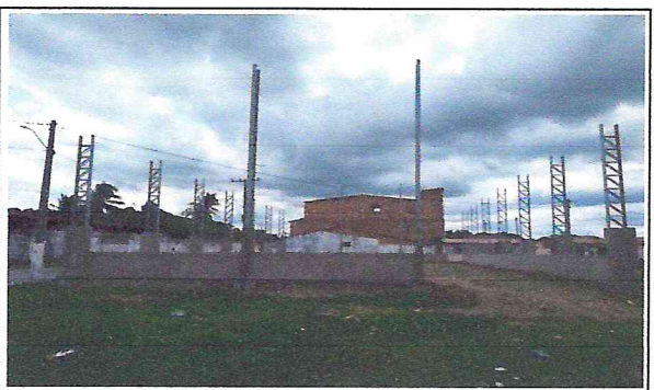
Foto 07: Pilares metálicos treliçados
