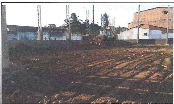
Foto 03: Realização de aterro
