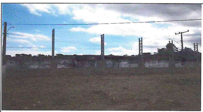
Foto 06: Pilares metálicos treliçados
