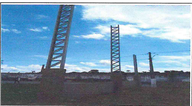
Foto 08: Pilares metálicos treliçados
