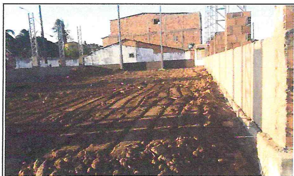
Foto 01 - Aterro para área do piso
