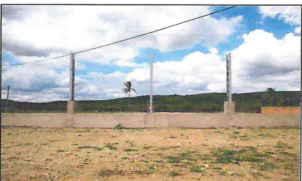
Foto 05: Pilares metálicos treliçados
